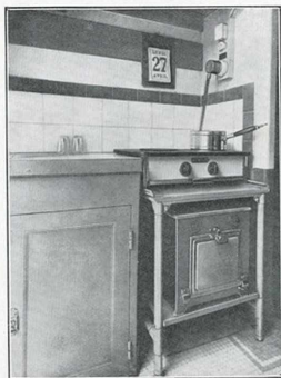
Fig. 2. — Petite cuisine équipée avec un réchaud à 2 plaques et 1 four. Puissance totale 2,5 kW.
